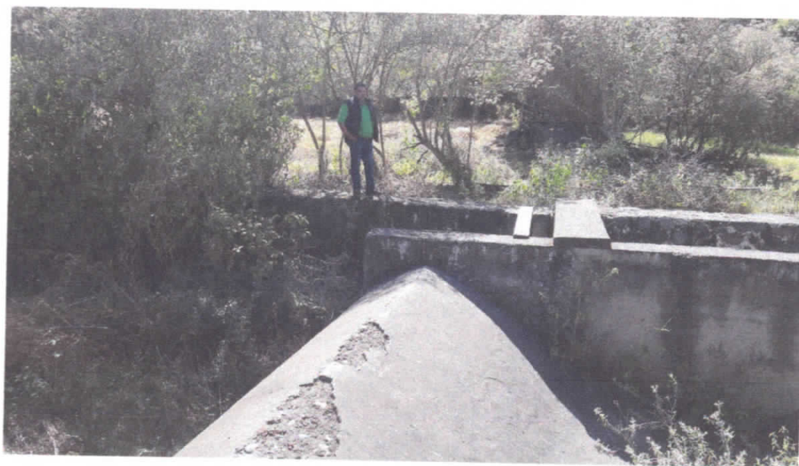
Revisión de la compuerta en el arroyo de la barranca de las cebollas a la cañada, Tuxcueca.
