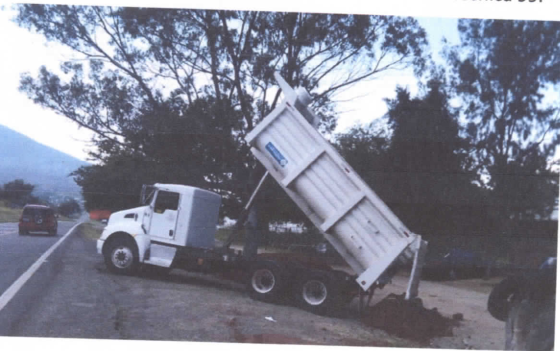
Se rehabilito rampa frente a la secundaria técnica 99.
