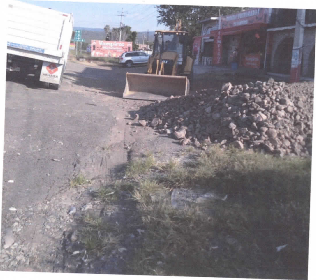
Se nivelo el área frente a vampiros Tuxcueca, en zona federal.
