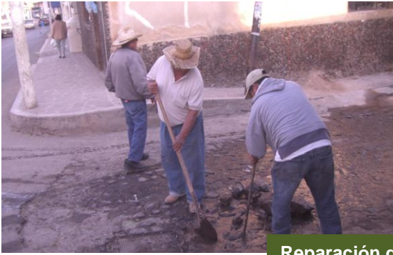
Reparación de fugas de agua
