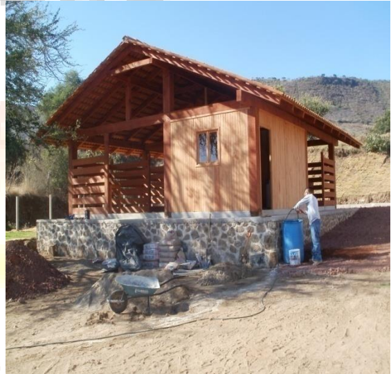
Construcción del Centro de Acopio
