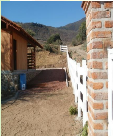
Construcción del Centro de Acopio
