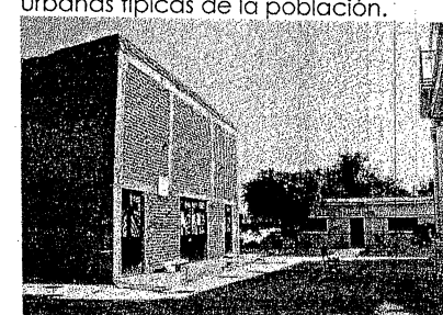
Adecuaciones deficientes en espacios urbanos.
