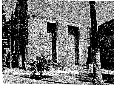
Elementos tipológicos no adecuados para el contexto
