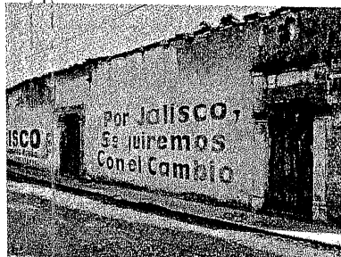
Casona esquina con a la plaza principal
